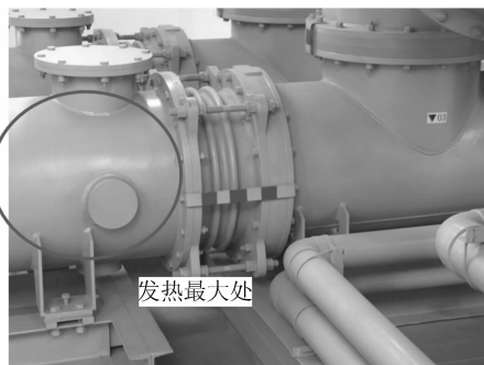
图 3 设备发热最大点
